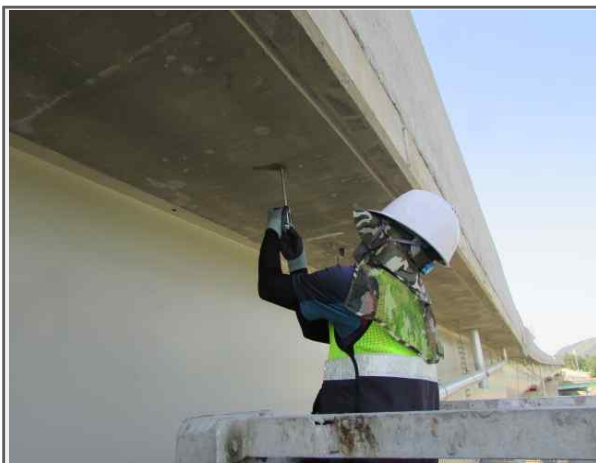
상부구조 탄산화깊이 측정
