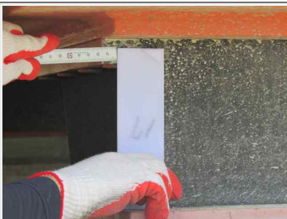
P2 교량반침 이동량 측정(상주)
