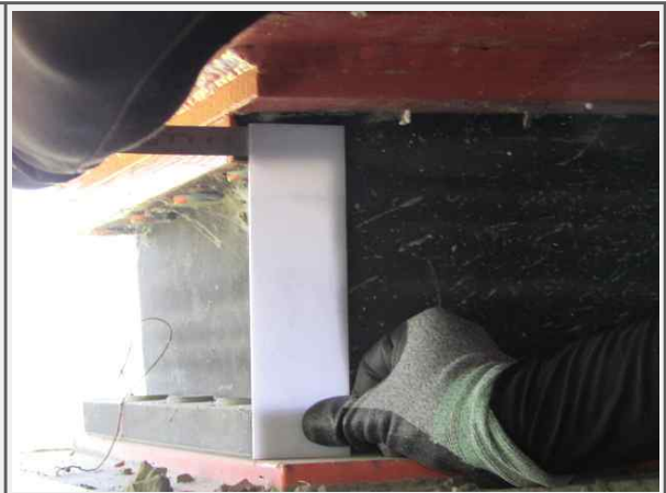
A2 교량반침 이동량 측정(영천)
