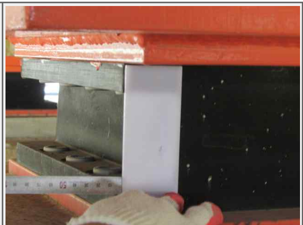
P1 교량반침 이동량 측정(영천)
