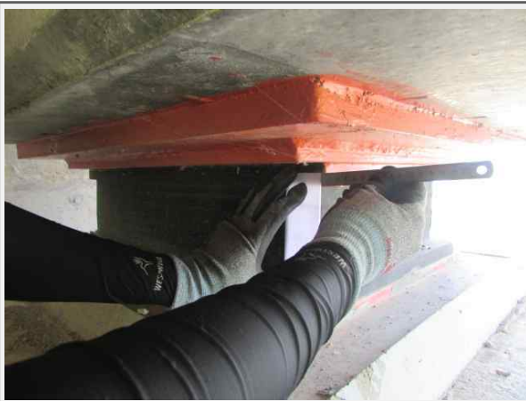
A1 교량반침 이동량 측정(상주)
