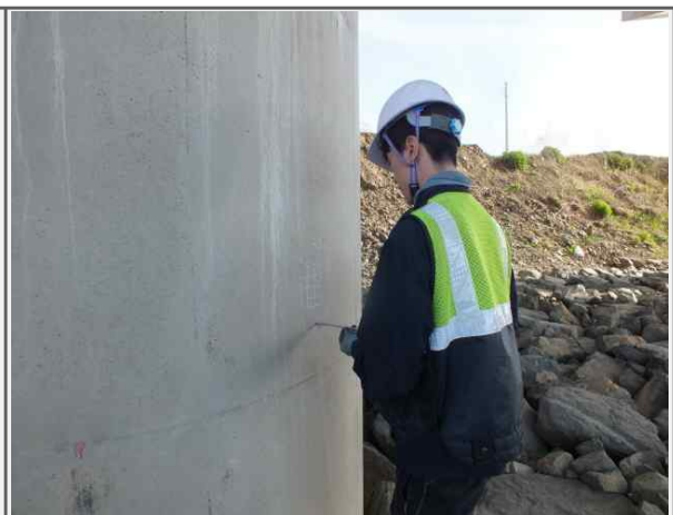
하부구조 탄산화깊이 측정
