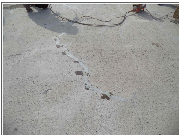
내 용 교면포장 균열보수
