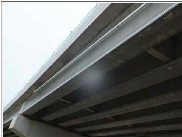
내 용 단포교(상주) 거더
