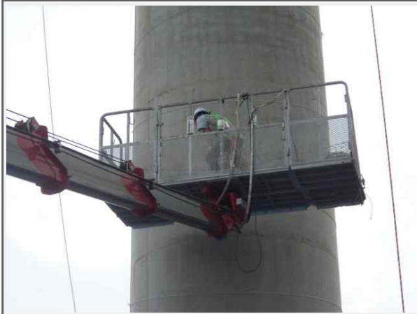
내 용 교각 균열보수 현황
