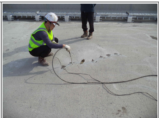
내 용 교면포장 균열보수 현황
